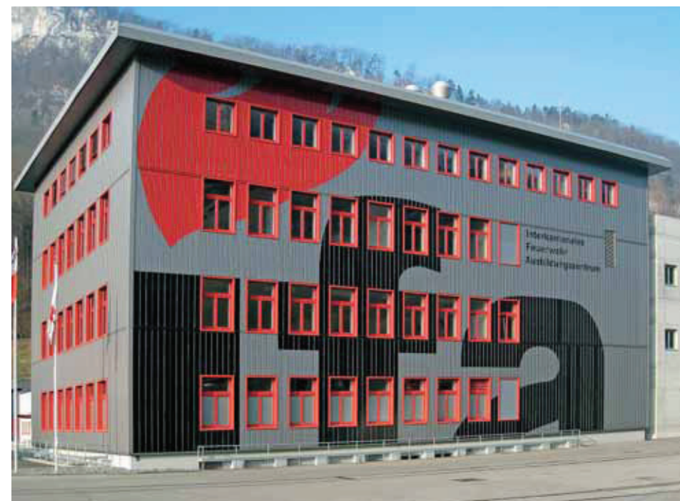
Infrastrukturgebäude des Interkantonalen Feuerwehr-Ausbildungszentrums ifa.
